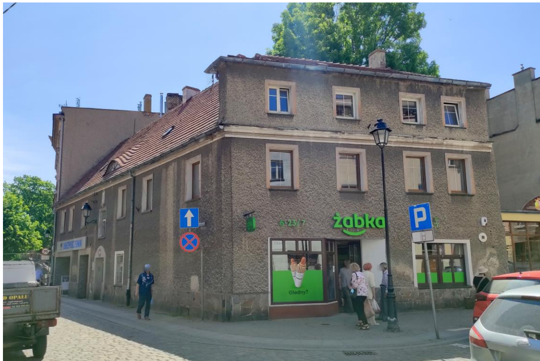
Widok budynku od północnego – zachodu.
