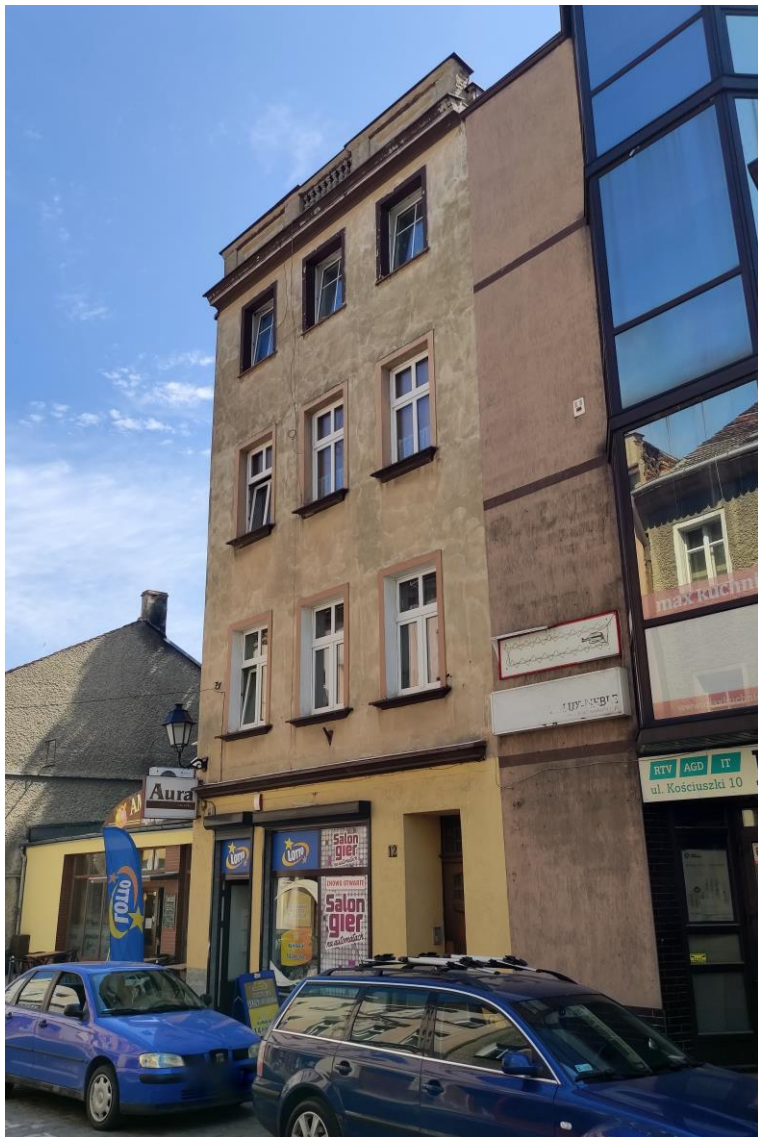
Widok budynku od południowego – zachodu.
