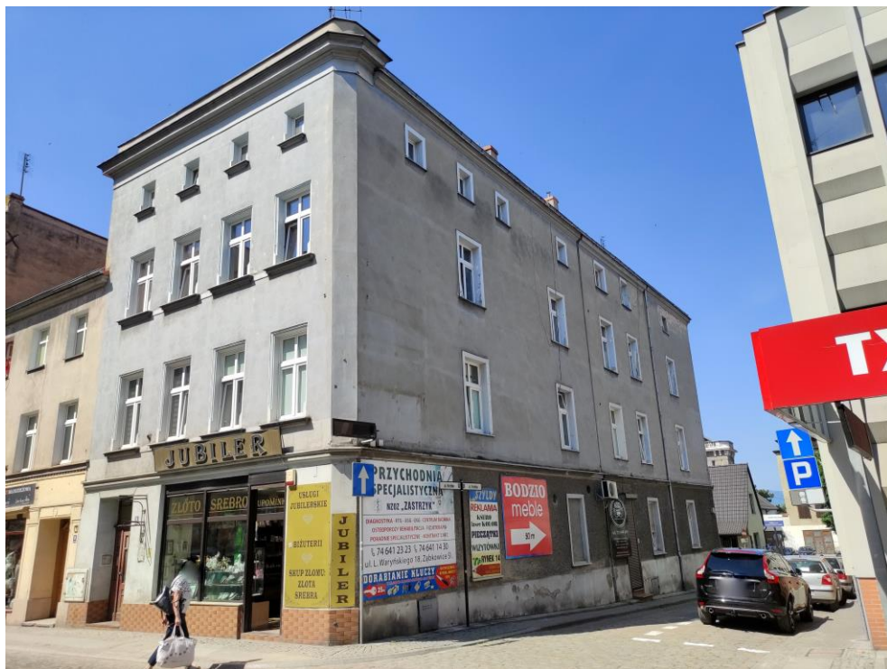
Widok budynku od północnego – wschodu.
