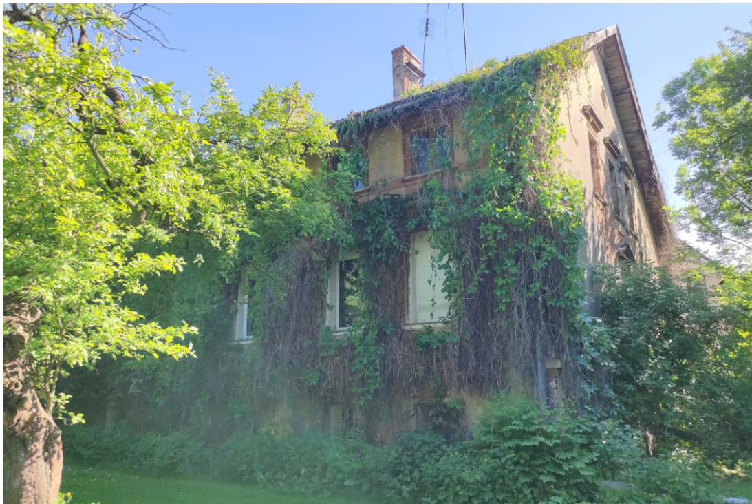
Widok budynku od północnego – wschodu.
