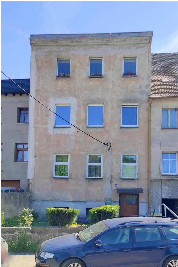
Widok budynku od północnego – wschodu.
