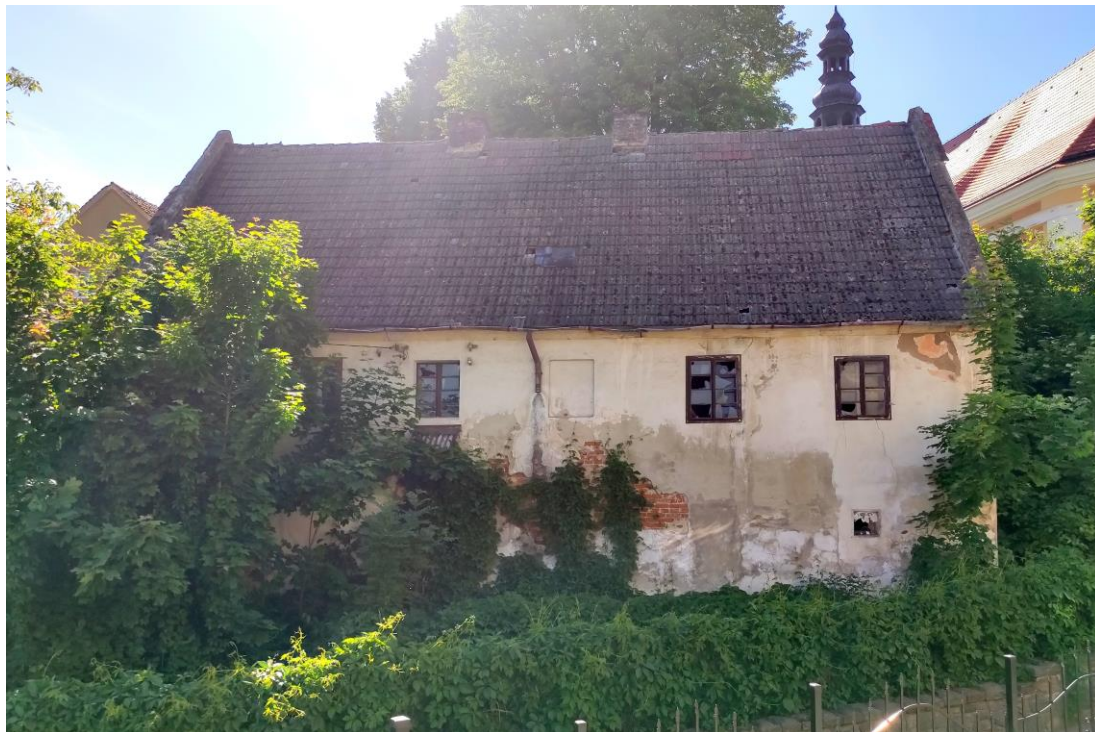
Widok budynku od południowego – wschodu.
