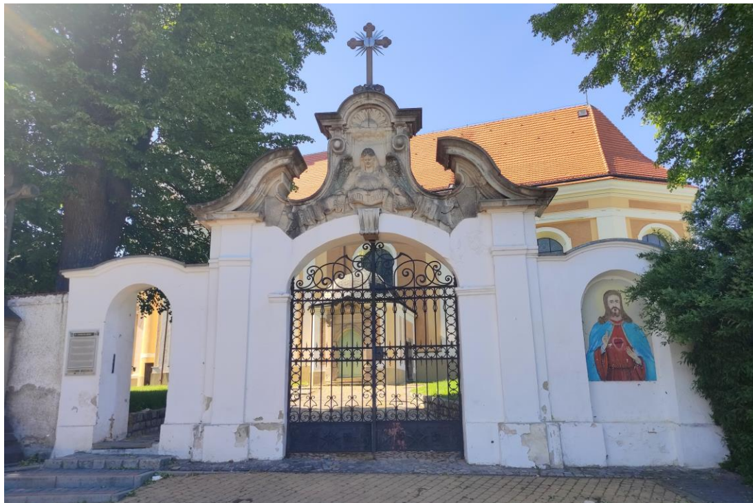
Widok od południowego – wschodu.
