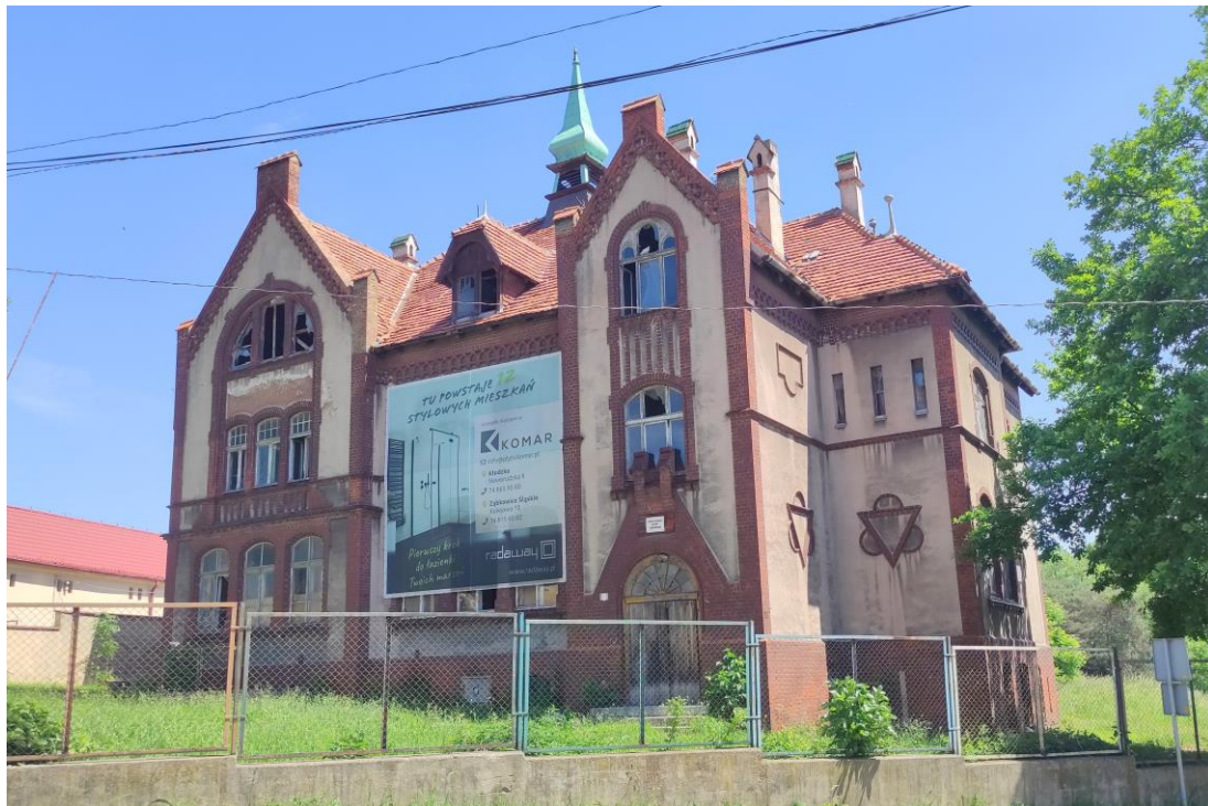
Widok budynku od południowego – zachodu.
