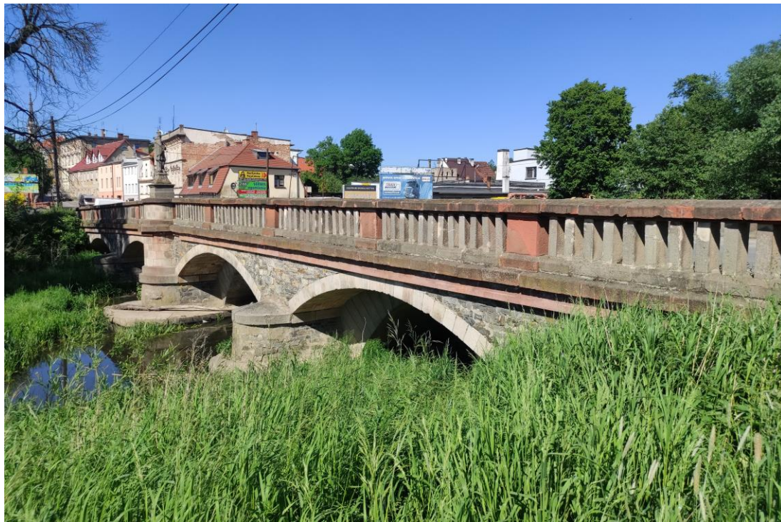
Widok od południowego – zachodu.
