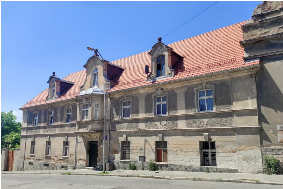
Widok budynku od północnego – wschodu.
