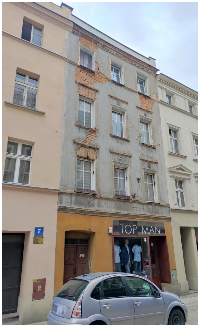
Widok budynku od południowego – wschodu.
