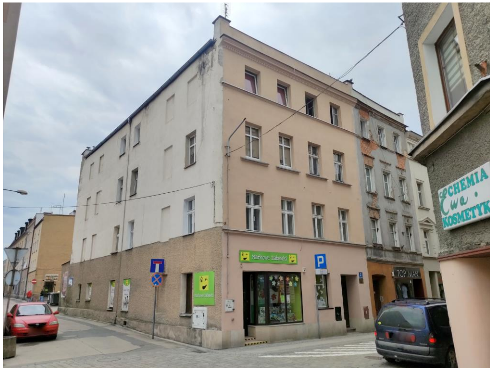
Widok budynku od południowego – wschodu.
