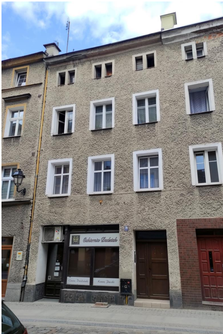
Widok budynku od północnego – zachodu.
