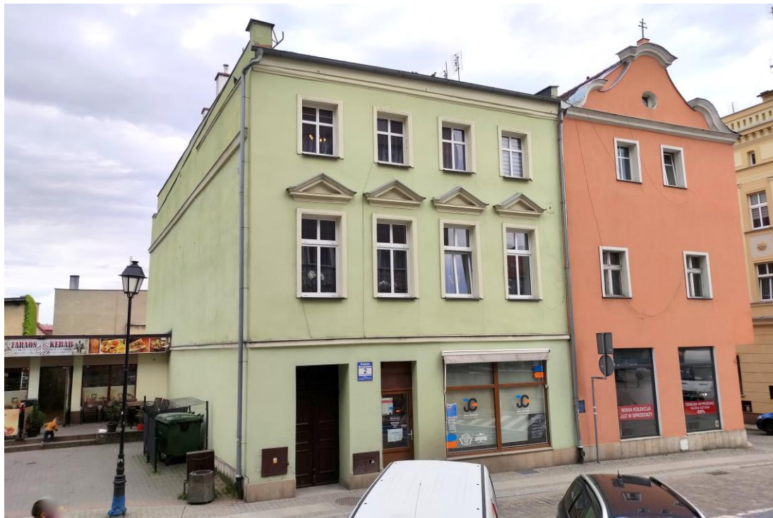
Widok budynku od północnego – zachodu.
