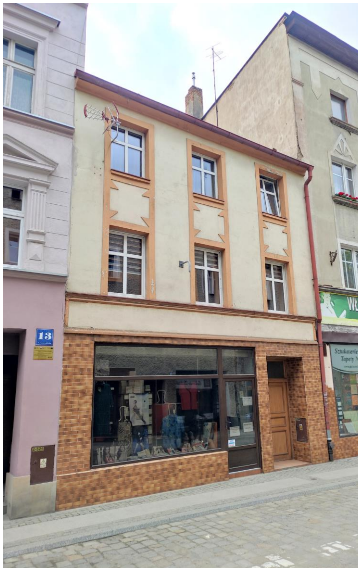
Widok budynku od południowego – wschodu.
