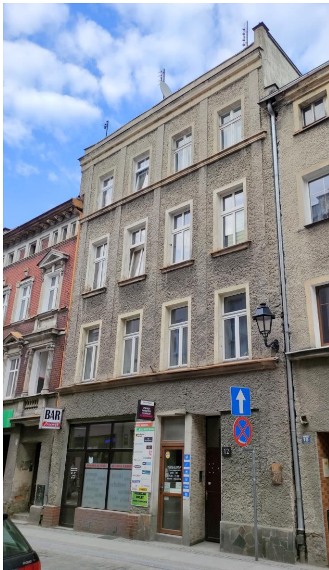
Widok budynku od wschodu.
