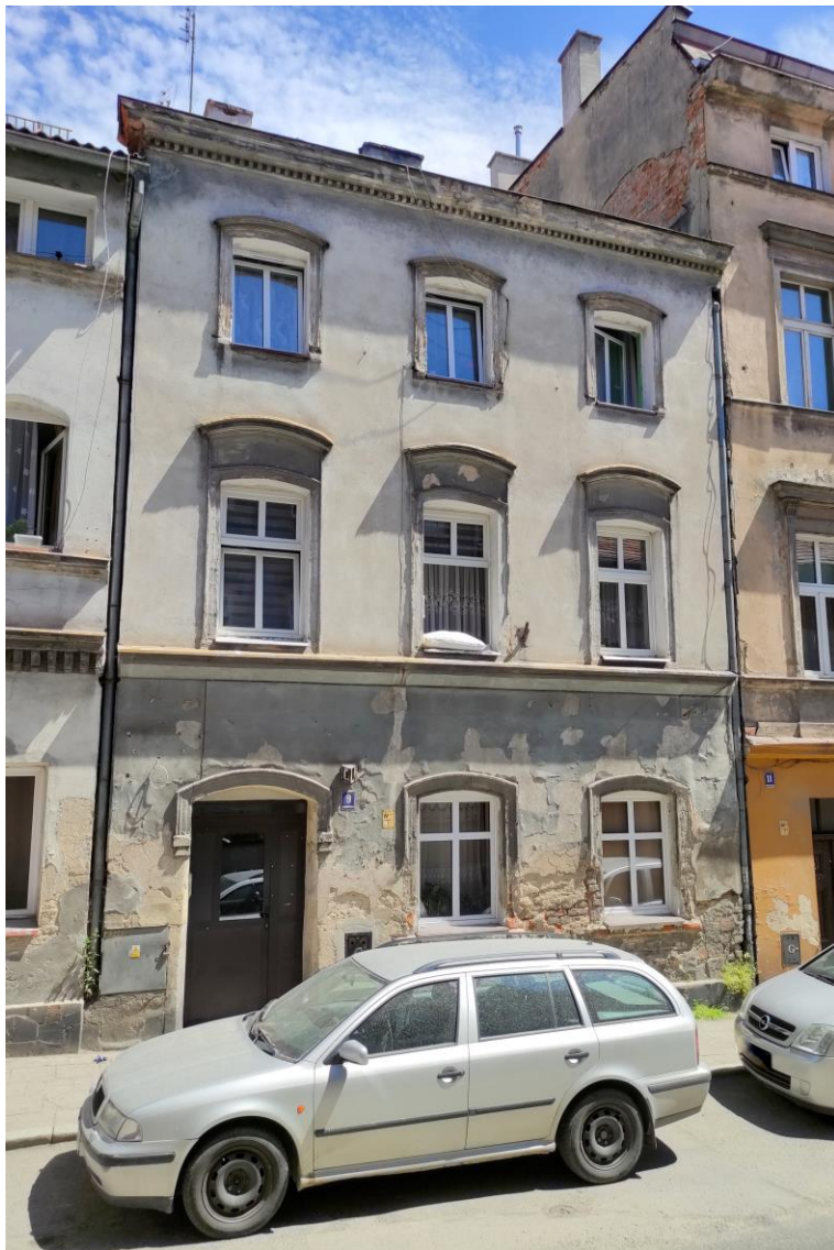
Widok budynku od północnego – zachodu.
