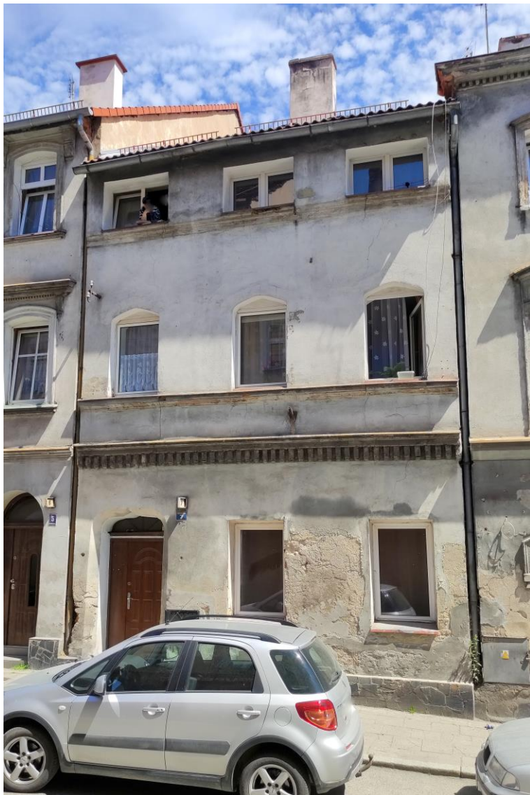
Widok budynku od północnego – zachodu.
