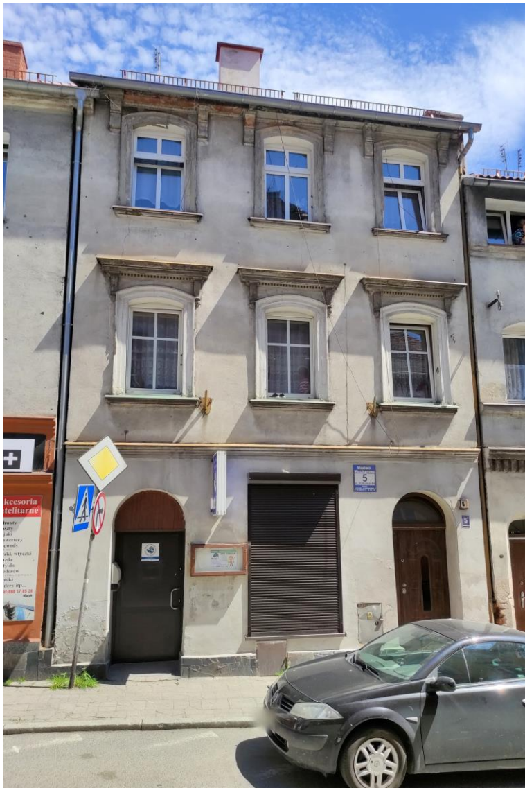
Widok budynku od północnego – zachodu.
