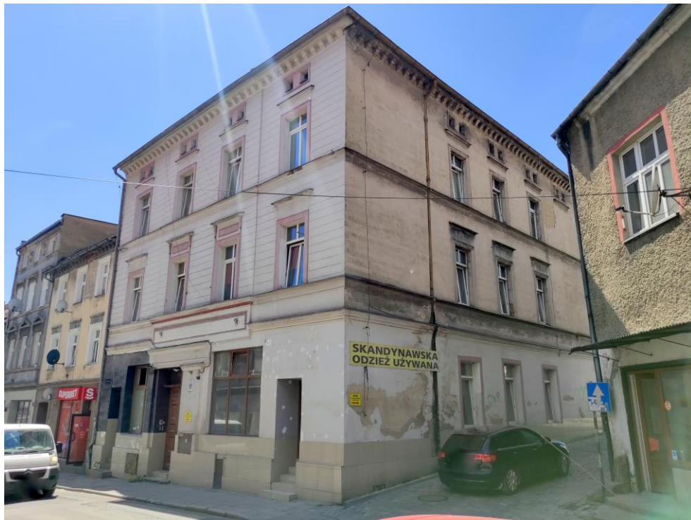
Widok budynku od północnego – wschodu.
