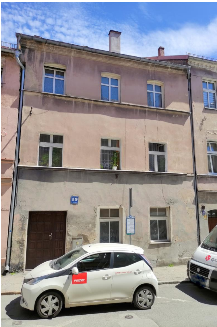
Widok budynku od północnego – zachodu.
