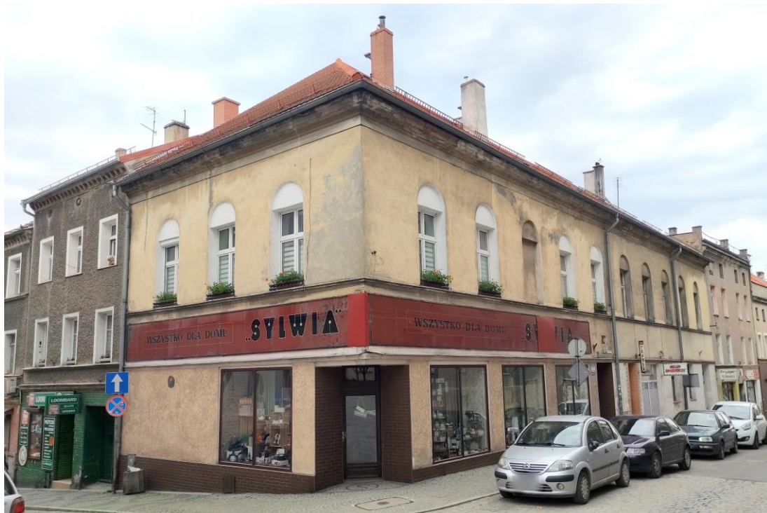
Widok budynku od północnego – zachodu.
