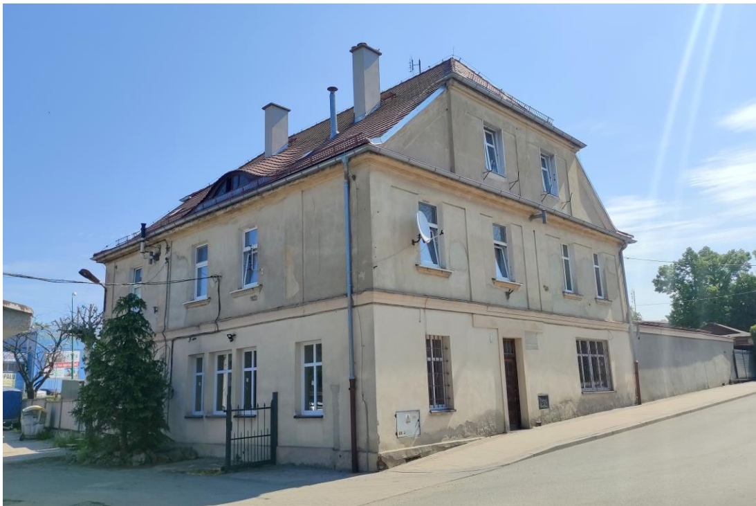
Widok budynku od południowego – zachodu.
