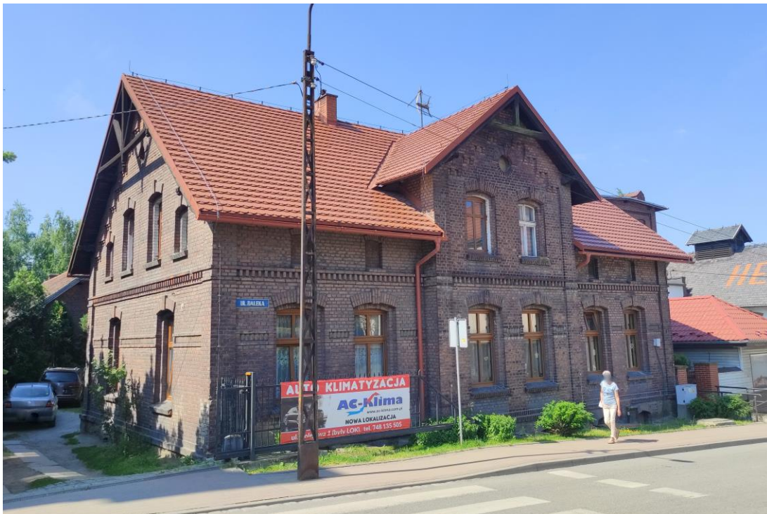
Widok budynku od północnego – wschodu.
