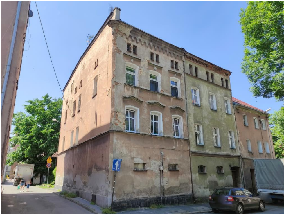
Widok budynku od północnego – wschodu.
