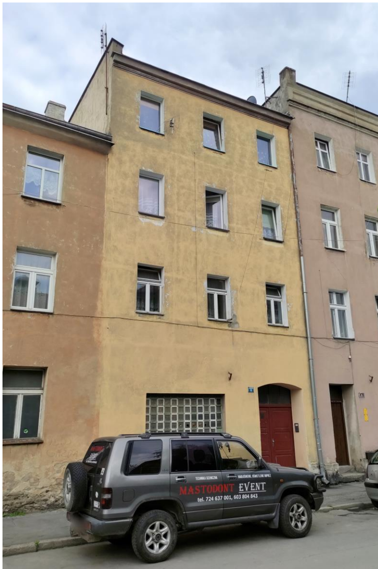
Widok budynku od północnego – zachodu.
