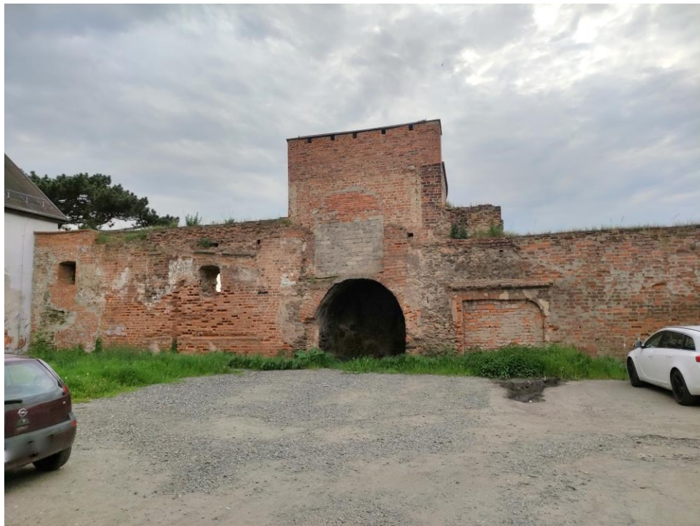
Widok budynku od północnego – wschodu.
