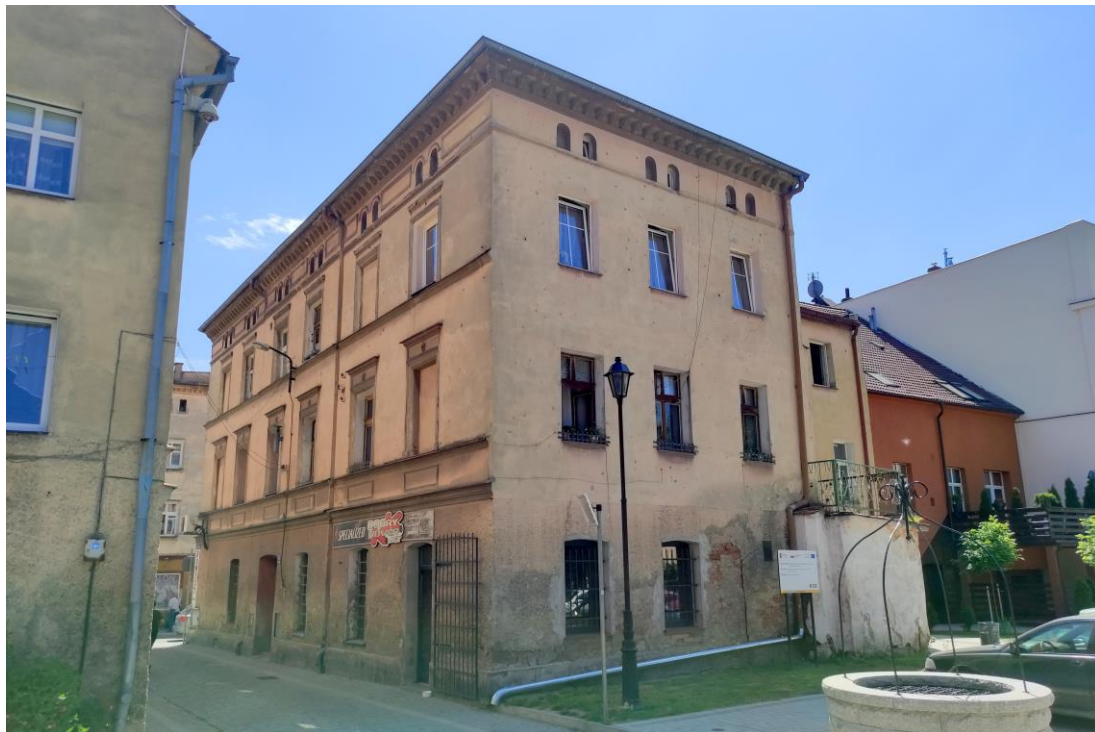
Widok budynku od północnego – zachodu.
