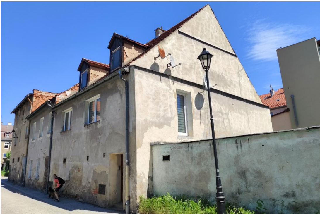
Widok budynku od południowego – zachodu.
