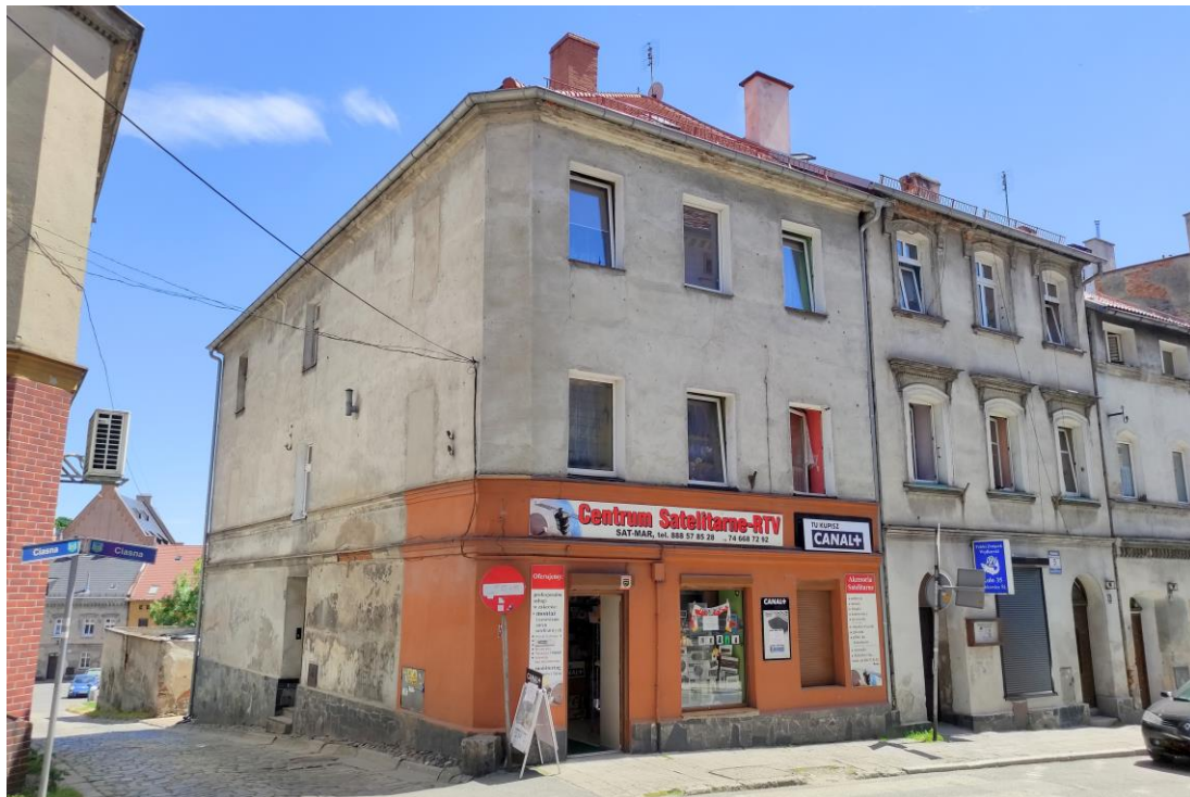
Widok budynku od północnego – zachodu.
