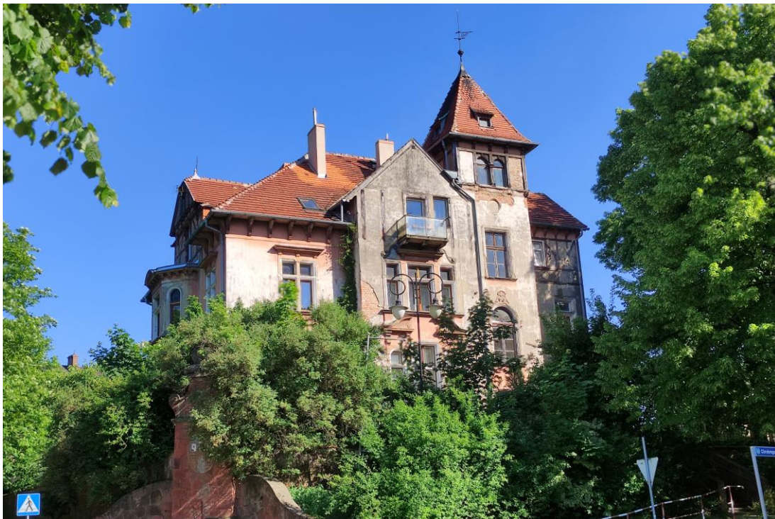
Widok budynku od północnego – zachodu.
