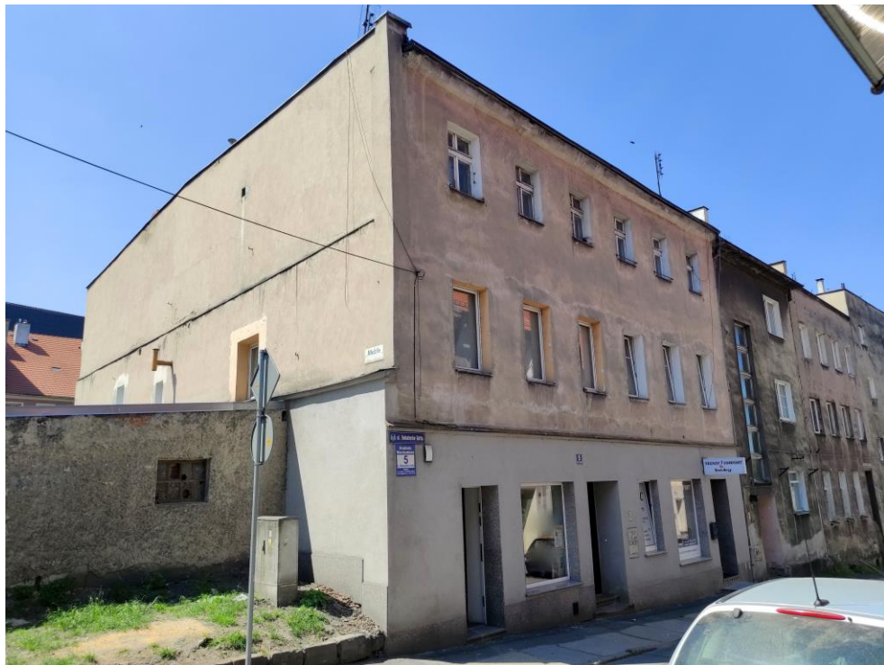
Widok budynku od północnego – wschodu.
