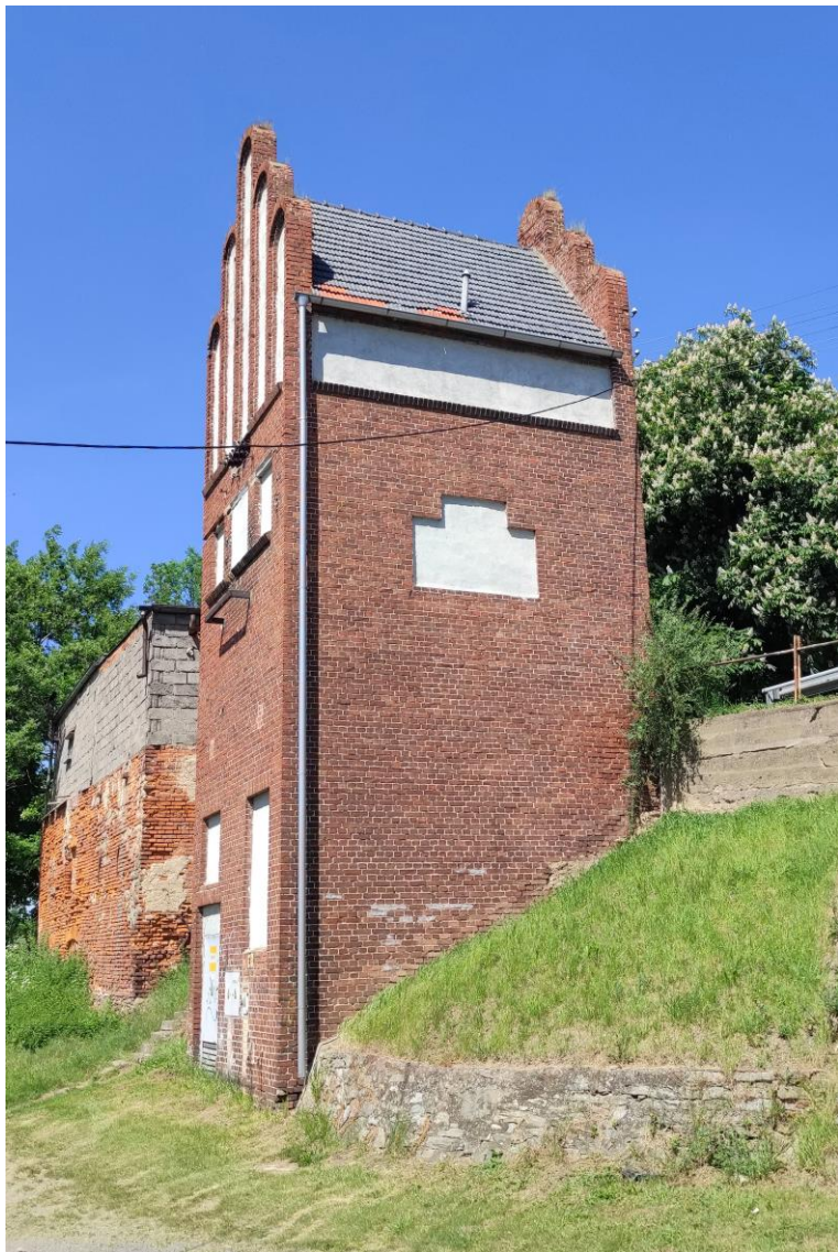
Widok od południowego – zachodu.
