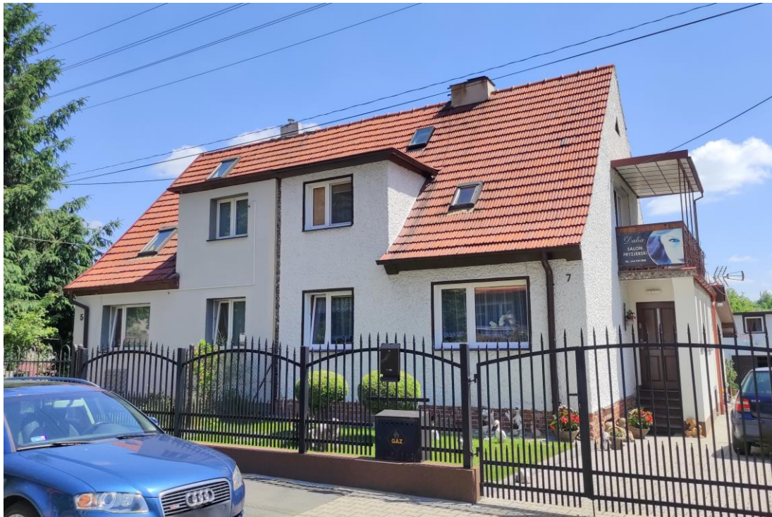
Widok budynku od wschodu.
