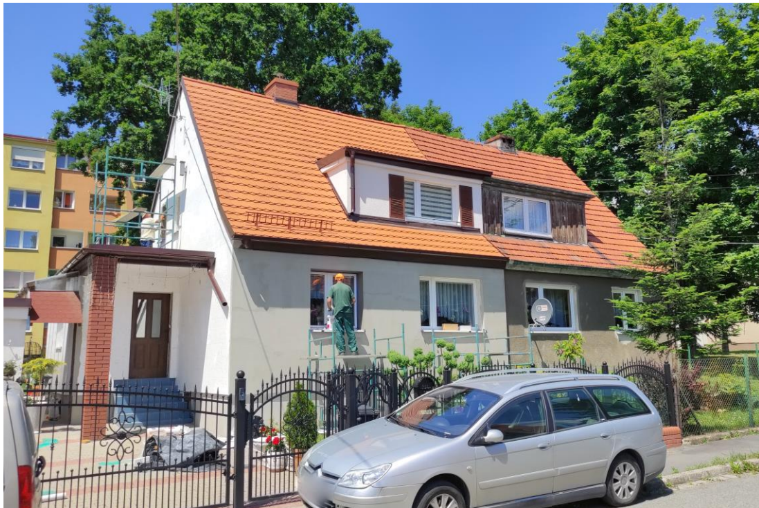
Widok budynku od południowego – wschodu.
