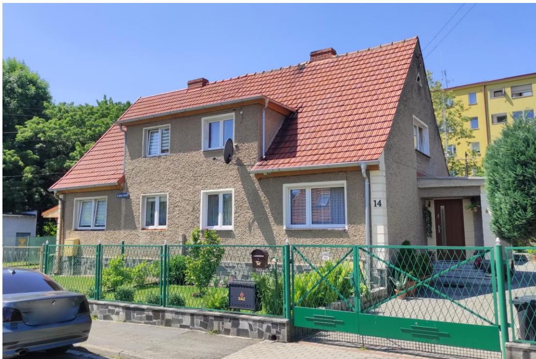
Widok budynku od północnego – wschodu.
