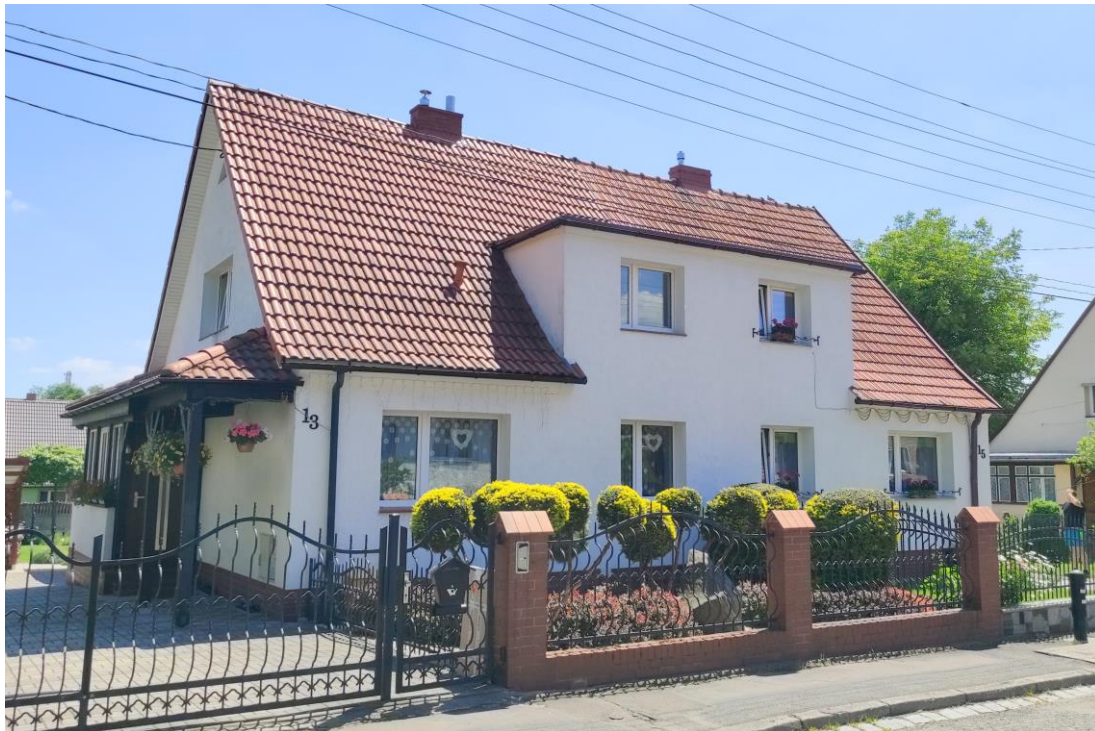
Widok budynku od północnego – zachodu.
