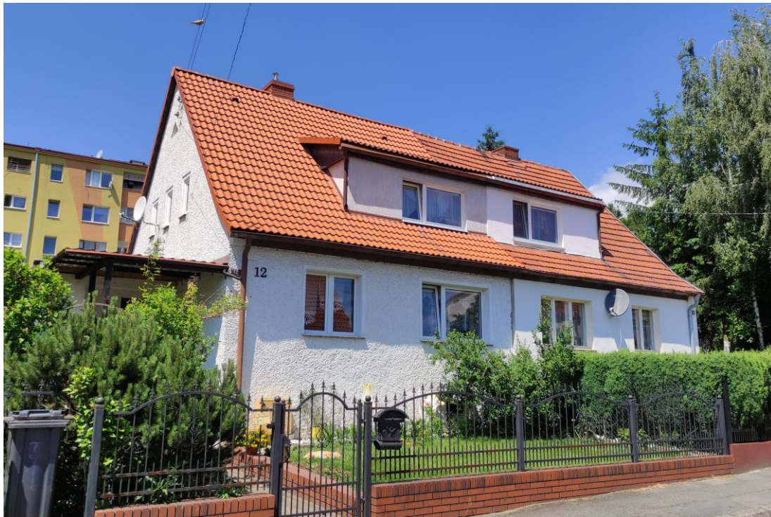
Widok budynku od południowego – wschodu.
