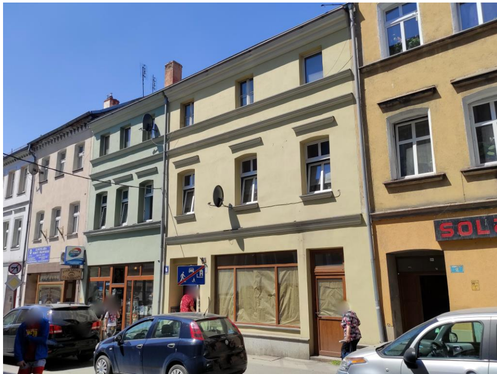
Widok budynku od wschodu.
