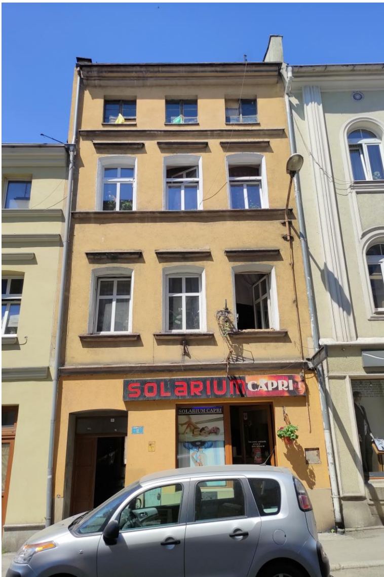
Widok budynku od południowego – wschodu.
