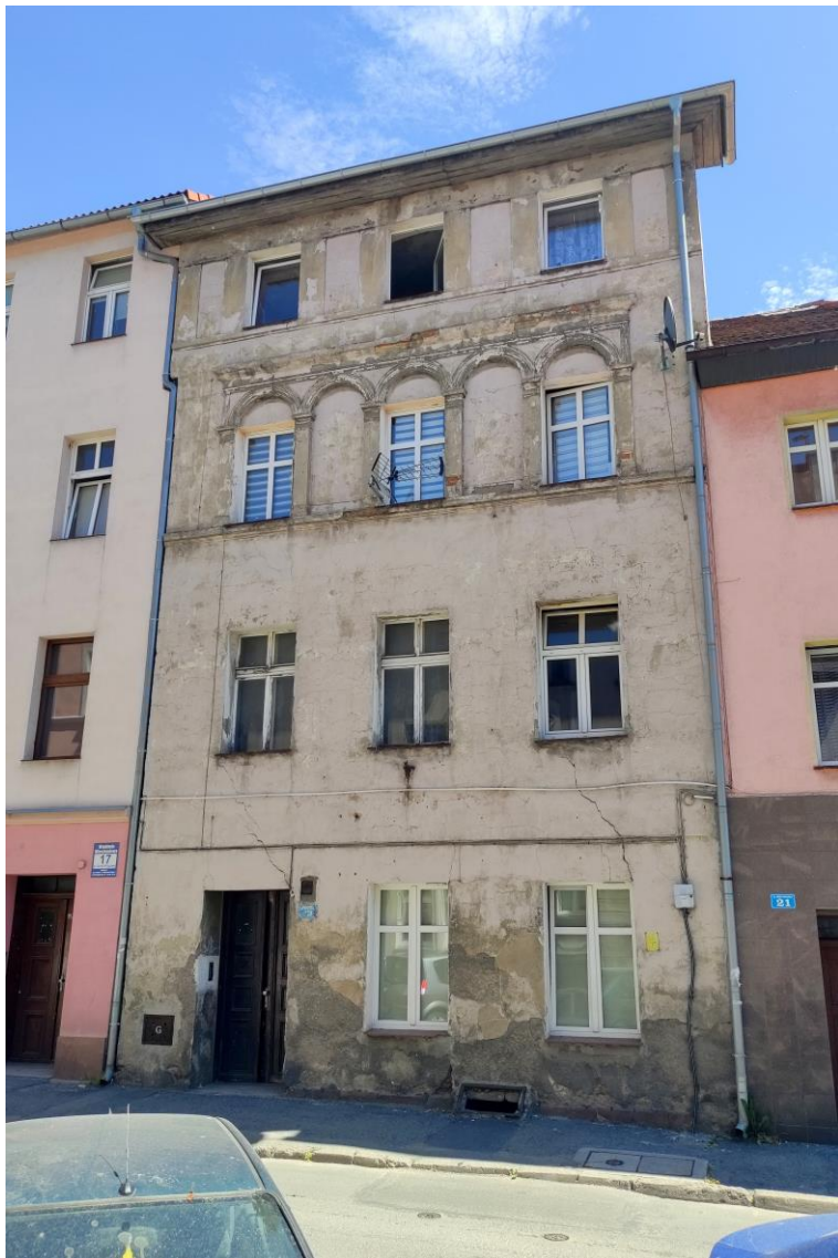
Widok budynku od północnego – zachodu.
