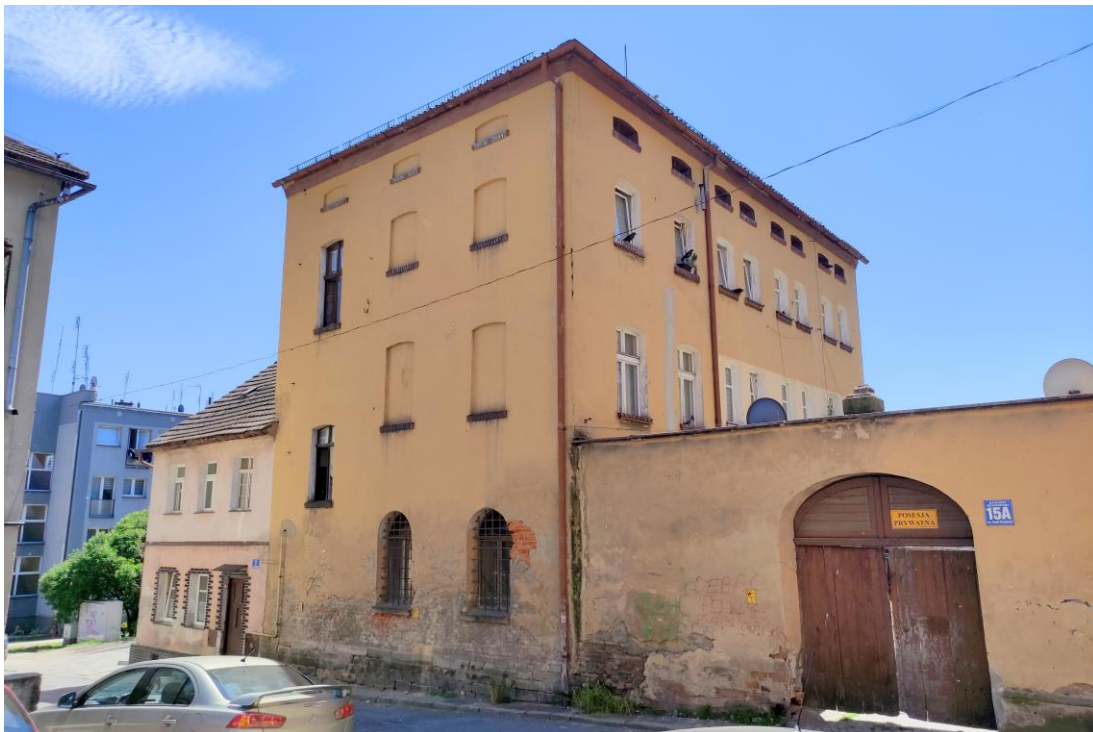
Widok budynku od północy.
