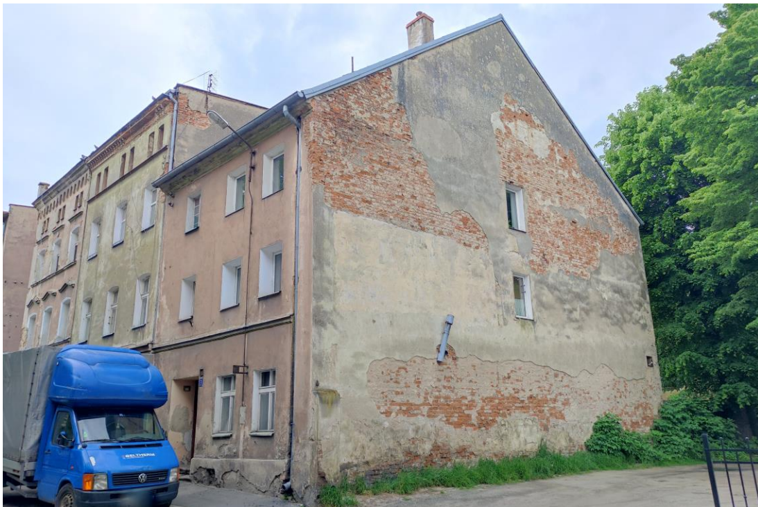
Widok budynku od północnego – zachodu.
