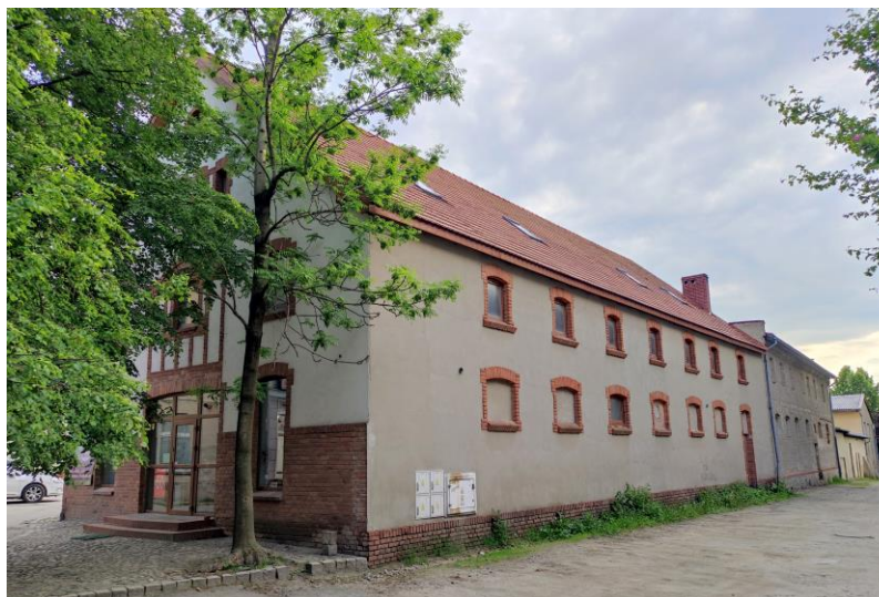
Widok budynku nr 7a od północnego – wschodu.
