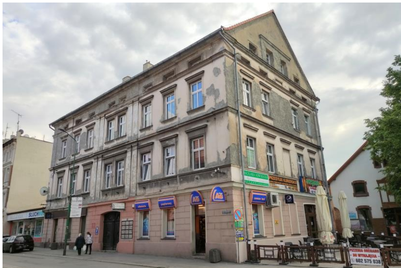
Widok budynku nr 7 od północnego – wschodu.
