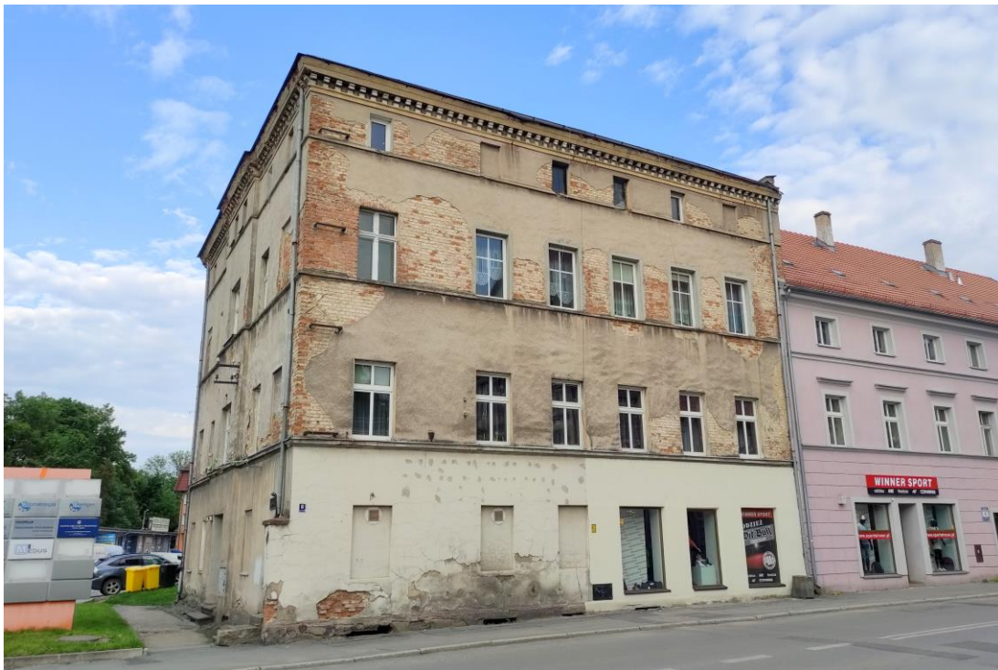
Widok budynku od północnego - zachodu.
