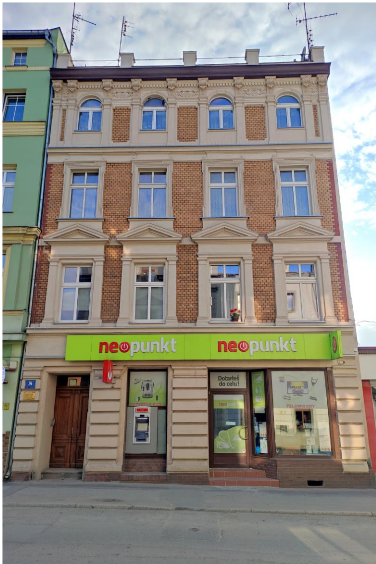
Widok budynku od wschodu.
