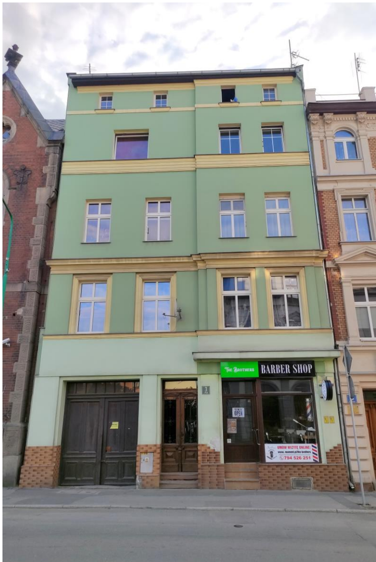
Widok budynku od południowego – wschodu.
