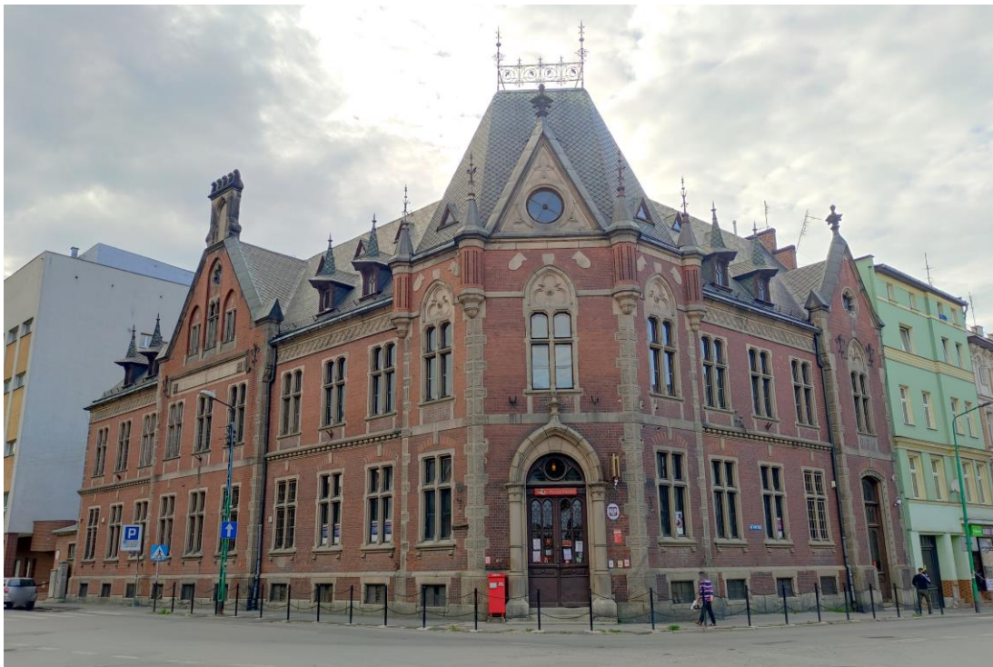
Widok budynku od południowego - wschodu.
