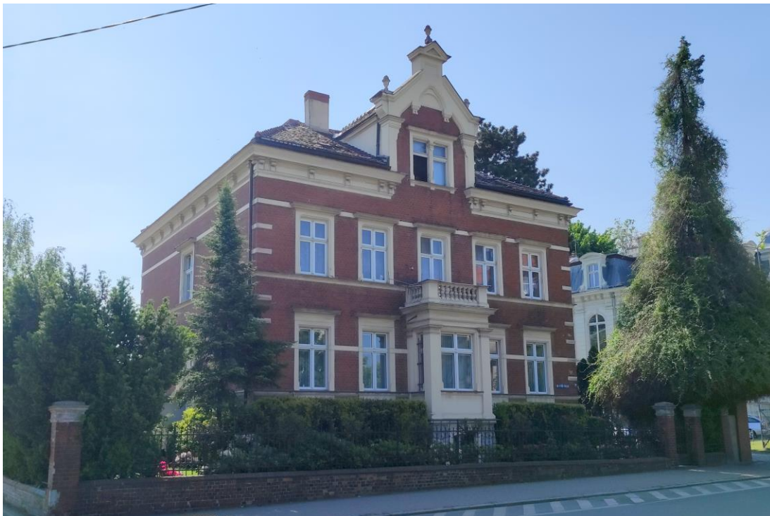
Widok budynku od północnego – zachodu.
