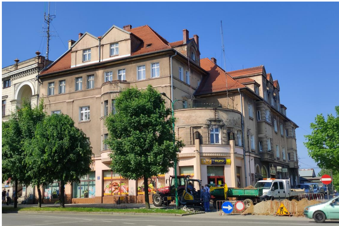
Widok budynku od północnego – wschodu.
